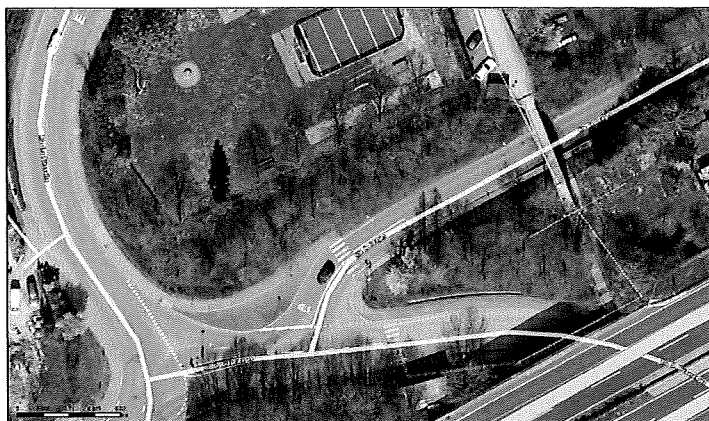
Figure 3 - Entrée ouest de la RC 80 (carrefour des Pressoirs)
